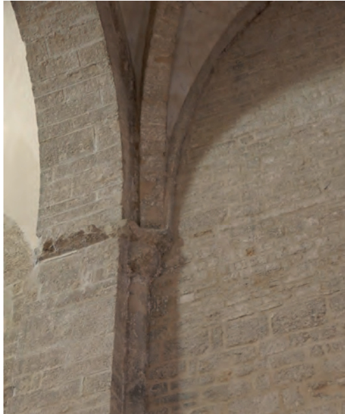
Abb. 8. Kathedrale von Acerenza: Bandrippengewölbe über dem Binnenchor, nordwestlicher Gewölbeanfänger.
