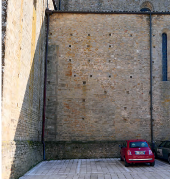
Abb. 5. Kathedrale von Acerenza: Langhaus-Nordseite, romanischer Mauerzug am Ostende mit diagonal verlaufender Baunaht.
