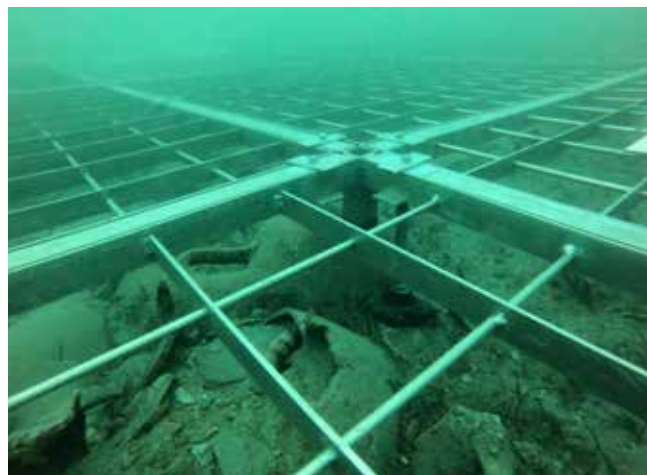
Fig.19: Relitto Grado 2. Le griglie subacquee per coprire, proteggere e garantire l'accessibilità al sito. (foto Università di Udine - M. Capulli)
